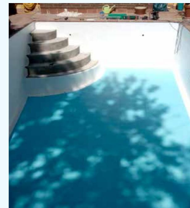
Otra ventaja es su **fácil y rápida instalación**. El liner puede instalarse en una piscina de nueva construcción, o bien, en la rehabilitación de una piscina, sustituyendo a un revestimiento ya existente.
